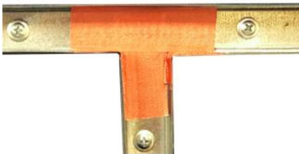
Рис.57. Пример обработки резаных краев ККМО.
