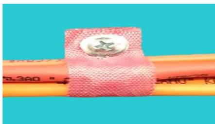
Рис. 7. Установка дюбель–хомута (Вариант 1).
