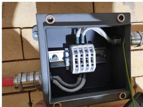
Рис. 46. Пример монтажа изоляторов термостойких керамических.
