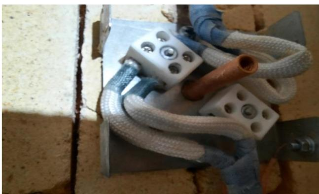
Рис. 50. Пример монтажа кабелей с использованием шнура-чулка ШК.
